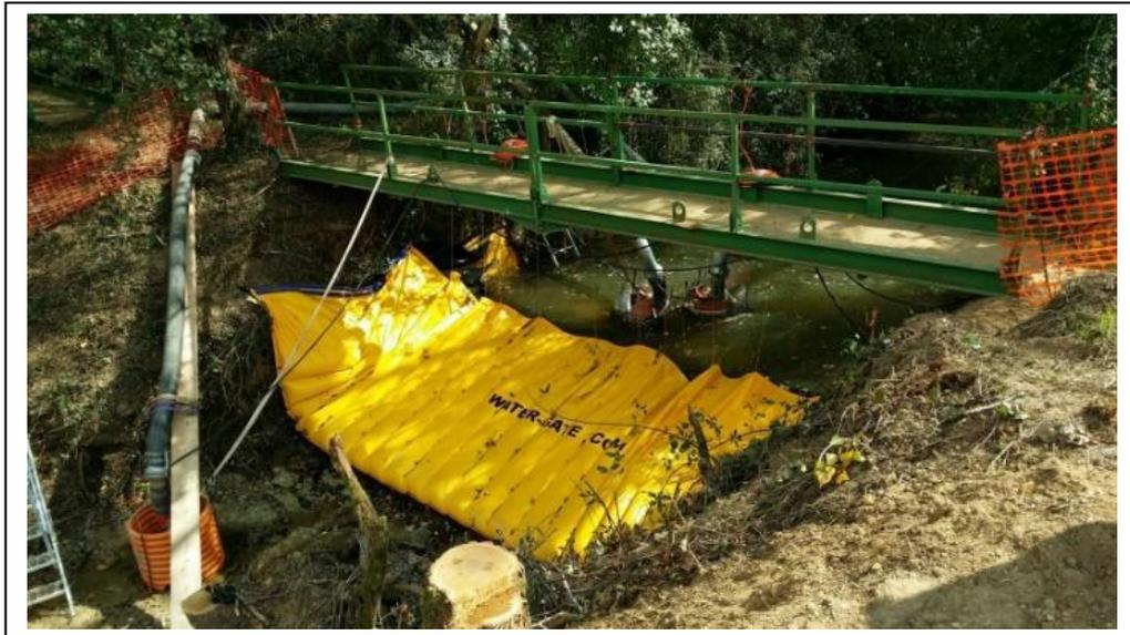
*Exemple de réalisation d'un batardeau pour mettre la zone de chantier en assec.*
