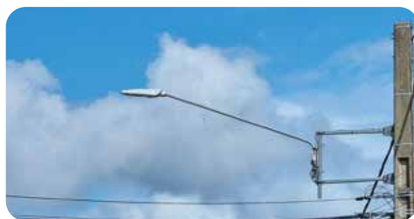
Après : poteau avec une lampe LED
